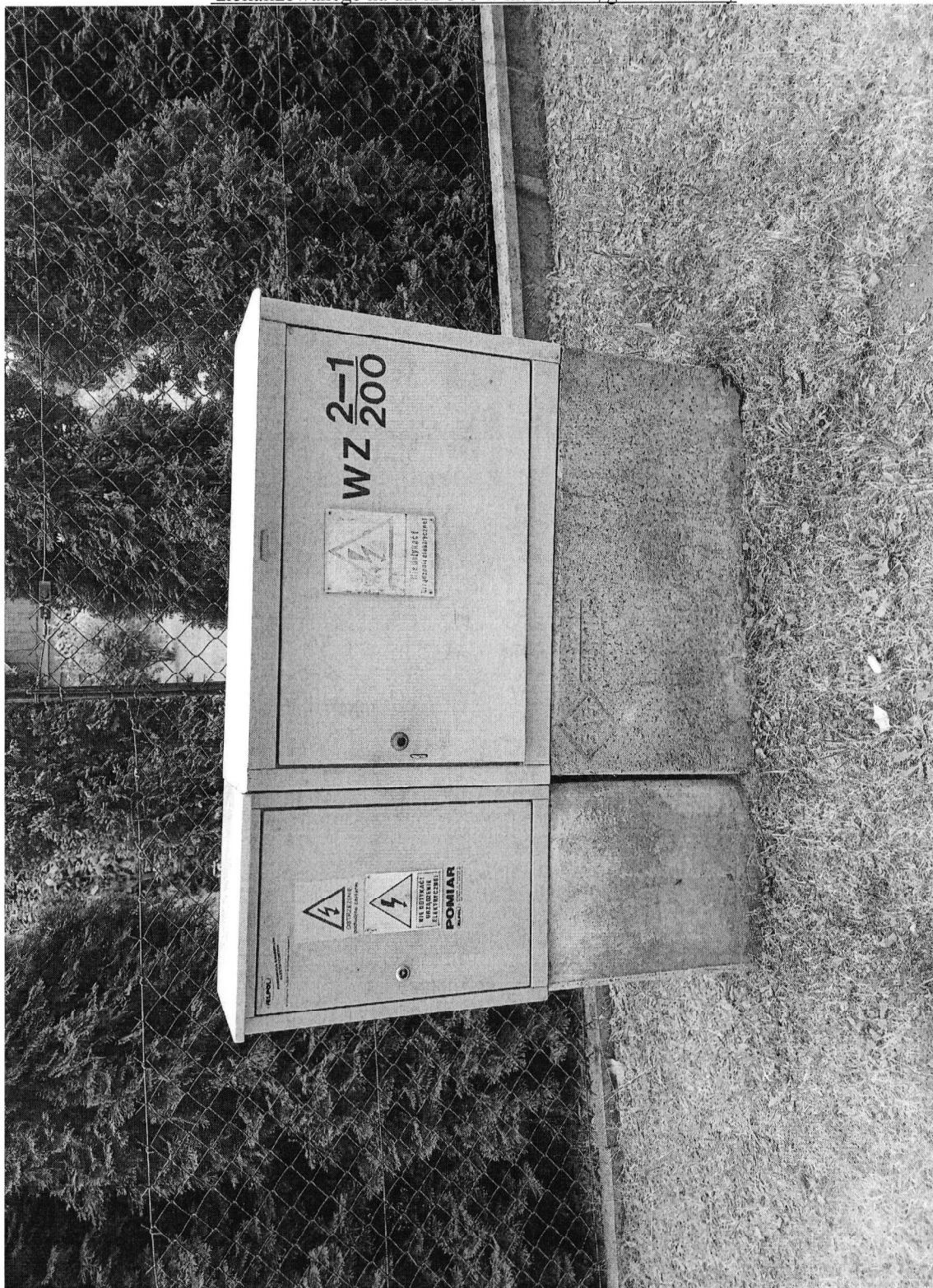
Złącze kablowe Z-2/1/200 typu ZK-1 przewidziane do wymiany na KRSN-00/2R-NH2/3R-NH00/F (zmiana nr złącza na Z3411435). Po lewej stronie P-1 „Ab”.
